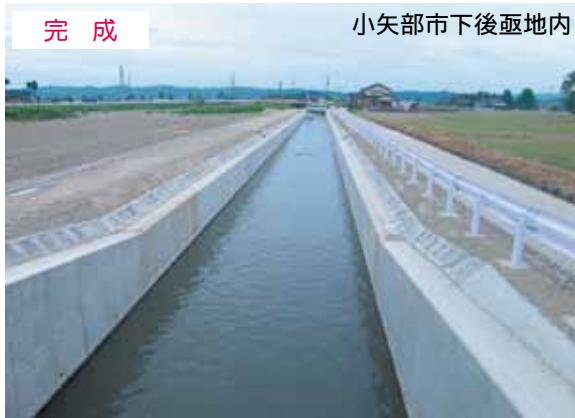
三方コンクリート水路（幅5.0m、高さ1.8m）
