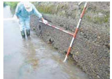
コンクリート擁壁が老朽化している様子
