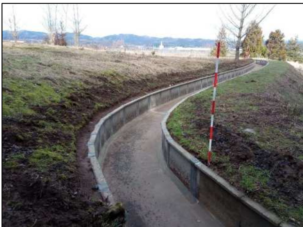
整備工事：水路目地補修工
