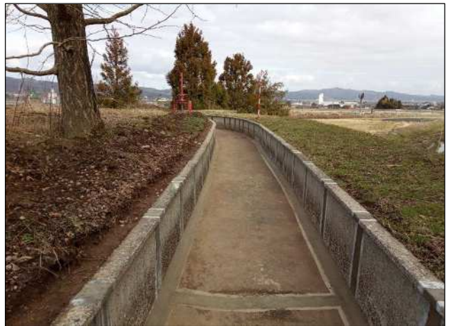
整備工事：水路目地補修工
