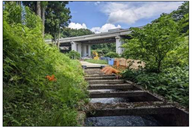
① 区間：第6工区仮設ポンプによる取水
