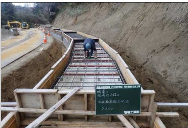
②区間：蓋版鉄筋組立状況
