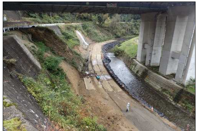
① 区間：河川内の仮設状況（高速道路高架下）
