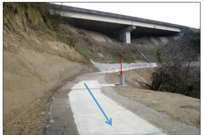
③区間：下流より望む（高速道路白谷橋付近）
