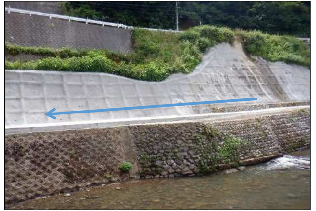
①区間：法面保護工（モルタル吹付）
