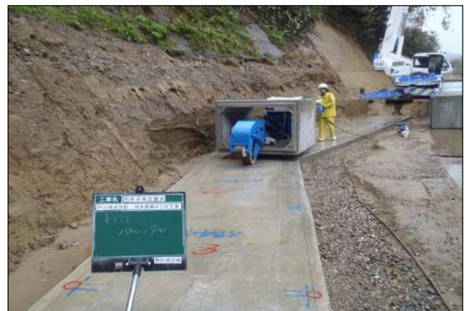
③区間：リフト付台車工法によるBOX布設
