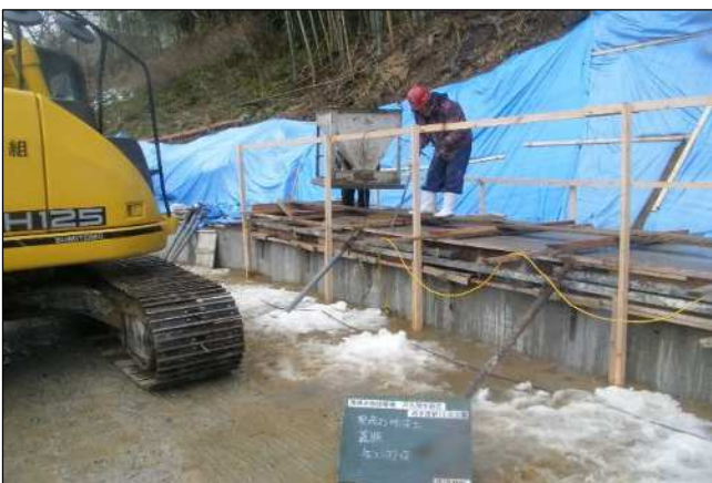
④区間：現場打暗渠工生コン打設状況
