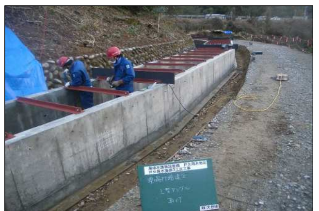
⑤区間：L型アンクル取付状況
