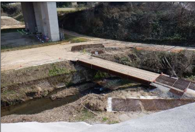
①区間：仮橋（渋江川）設置状況
