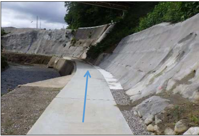
① 区間：上流より望む（高速道路高架下）
