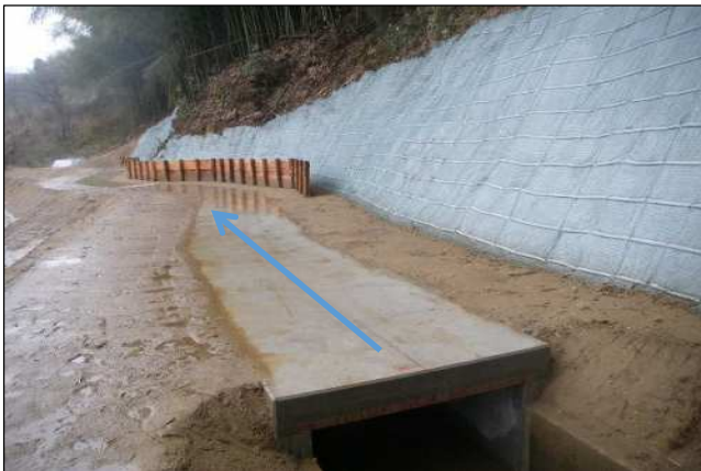
④区間：上流より望む
