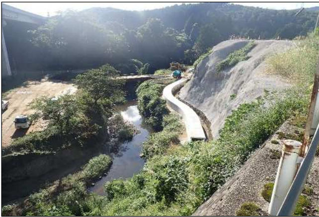
①区間：第6工区施工状況
