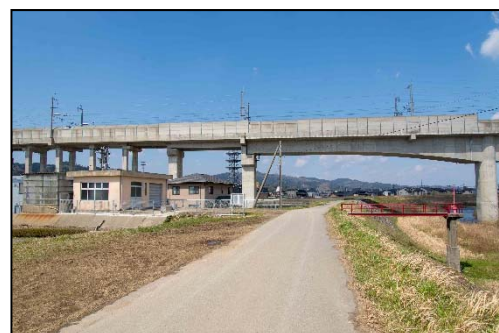
渋江川左岸上流から揚水機場を望む
