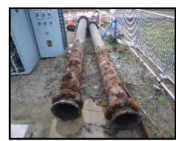
H30 揚水機配管撤去
