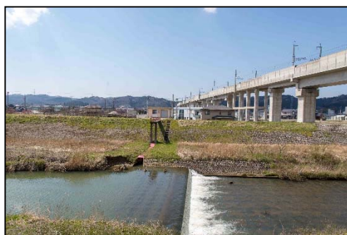
渋江川右岸から揚水機場を望む
