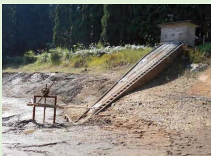
底樋ゲート（埋没）
