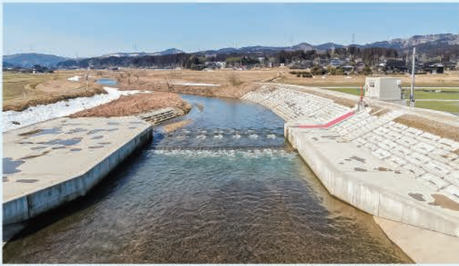
頭首工全景（下流から望む）
