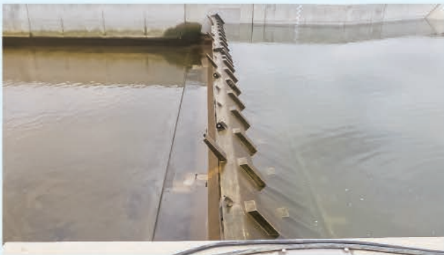
取水堰起立状態（左岸から望む）
