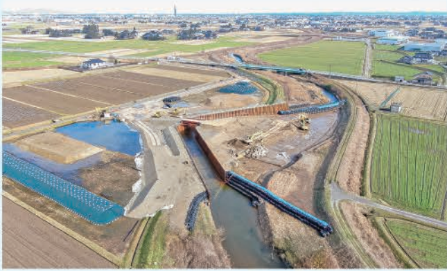
一次施工時の仮設状況：本体及び右岸側施工 (R2.1.6)
