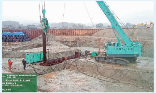
本体部：遮水矢板打設状況 (R2.1.31)
