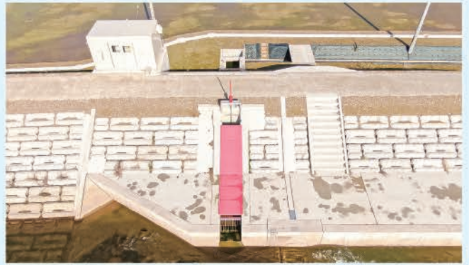
左岸取水口（上空から望む）
