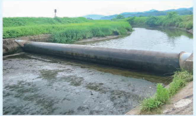
改修前の取水堰（下流から望む）
