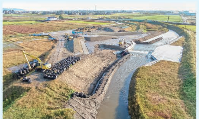
二次施工時の仮設状況：左岸側施工 (R2.11.3)
