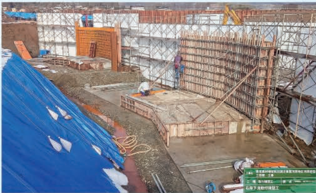
右岸側取付擁壁工：型枠組立状況 (R2.2.19)
