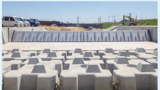
上流より取水堰本体を望む
