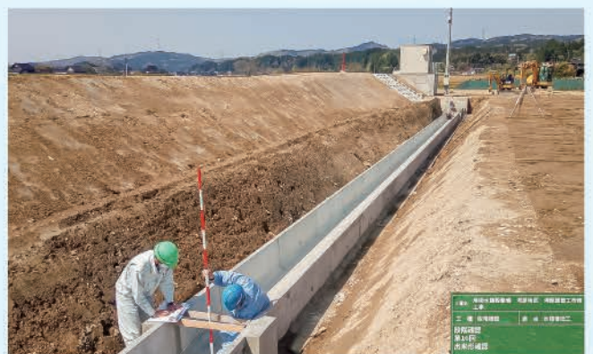
水路復旧工出来形確認状況 (R3.4.20)
