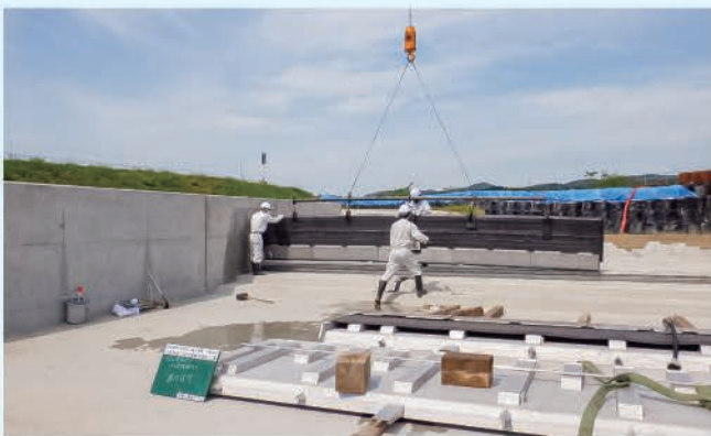
扉体据付状況 (R2.5.12)
