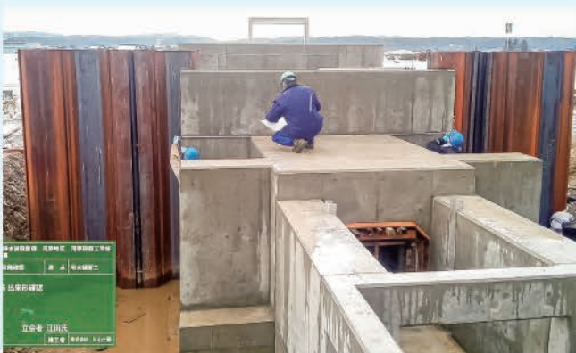
樋管工出来形確認状況 (R3.1.6)
