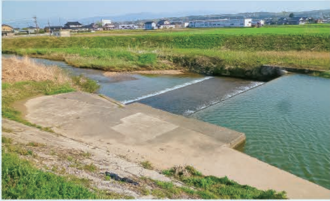
改修前の頭首工全景（上流から望む）
