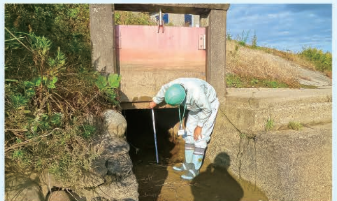
取水口状況 (H30.11.2)
