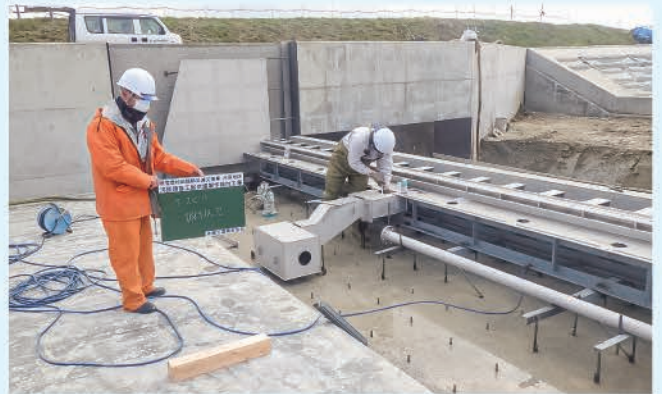
開閉装置据付状況 (R2.4.21)
