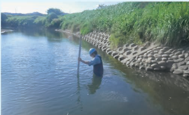
河床洗掘調査状況 (H27.9.29)
