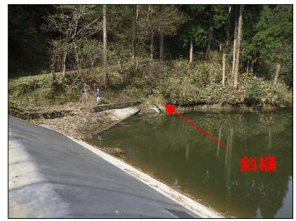
取水施設状況（右岸側より望む） 斜樋への管理用歩廊
