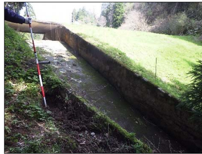
洪水吐状況（堤体上流望む） 洪水吐及び堤体
