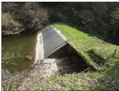
堤体状況（左岸側より望む） 遮水シート及び洪水吐
