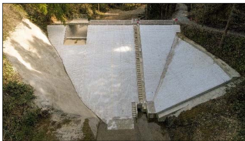
堤体状況（上空より望む） 布製型枠及び洪水吐
