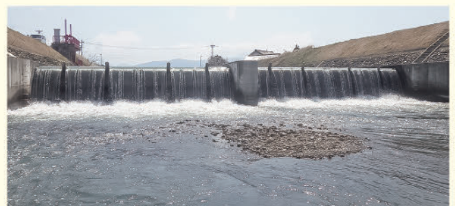
下流より望む（起立状態）
