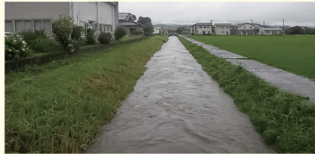
湛水被害状況：鷺島地内
