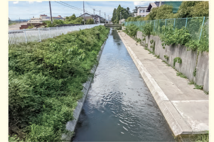
改修後の水路
