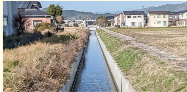
改修後の水路
