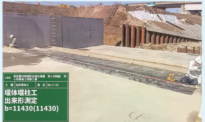
取水堰据付時の確認状況
