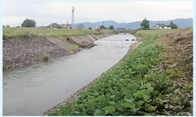
改修前の頭首工全景（左岸下流から望む）
