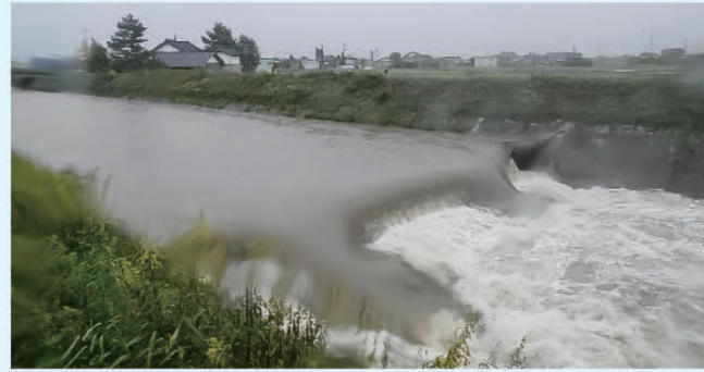
袋体の倒伏不良状況
