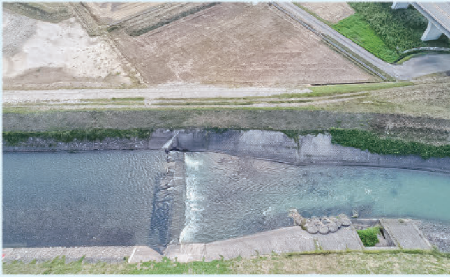
改修前の頭首工全景
