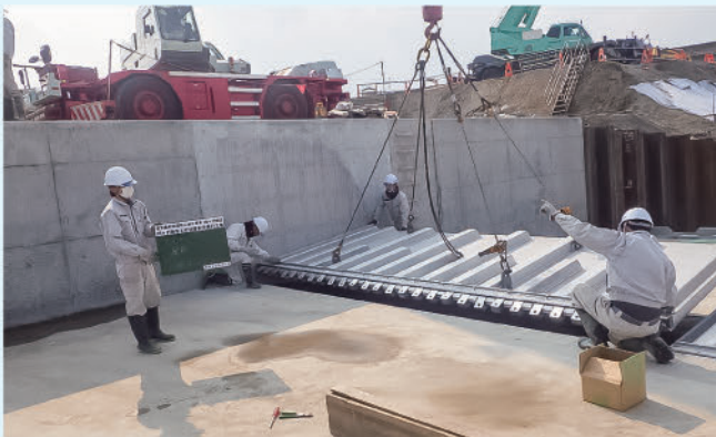
扉体据付状況(左岸側)
