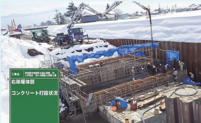
右岸堰体部生コン打設状況
