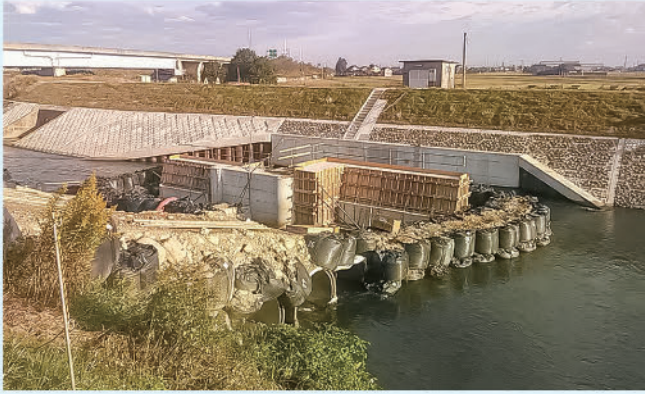
左岸施工時の仮設状況
