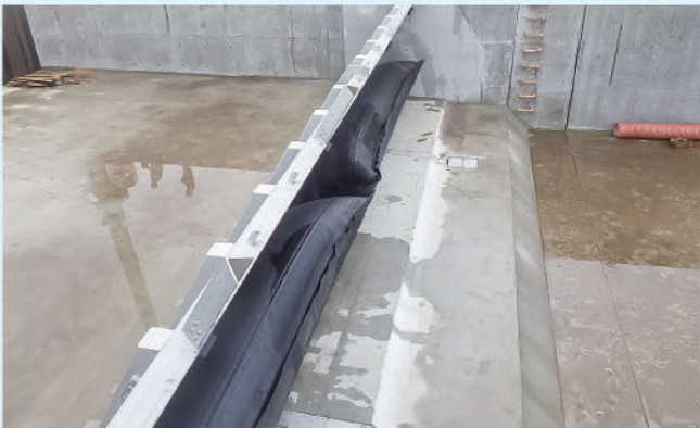
取水堰起立状態（右岸から望む）
