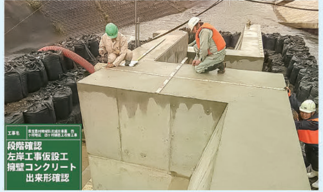
仮設擁壁工(左岸工事仮設工)
