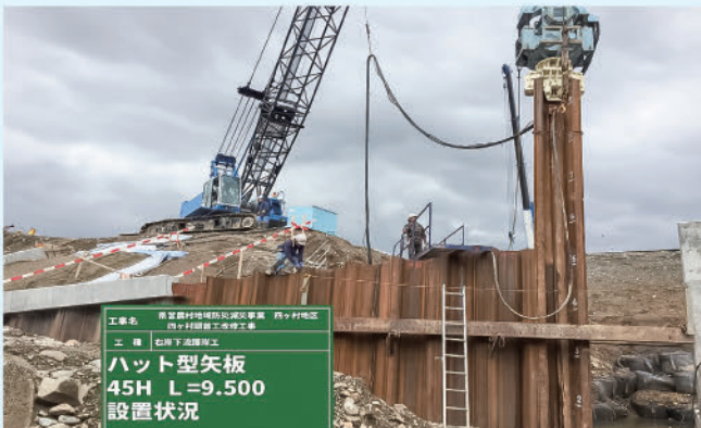
護岸矢板打設状況
