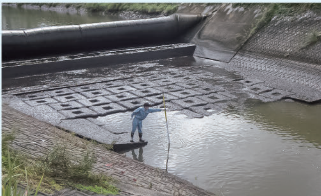
下流エプロン工全景
