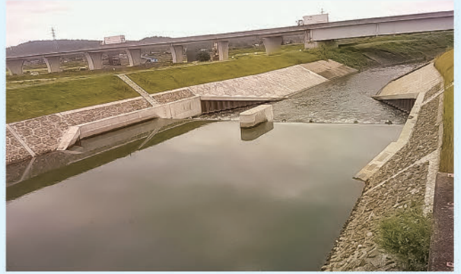
頭首工全景（上流から望む）
