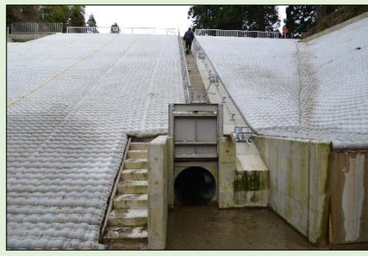
底樋状況 土砂吐水門
