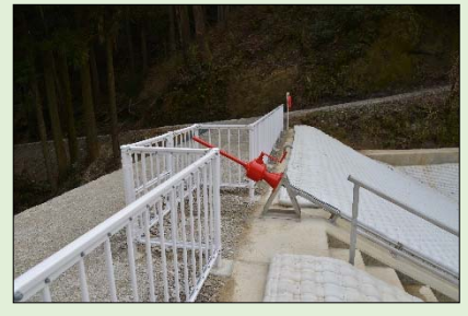
取水施設状況（右岸側より望む） 巻上水門
