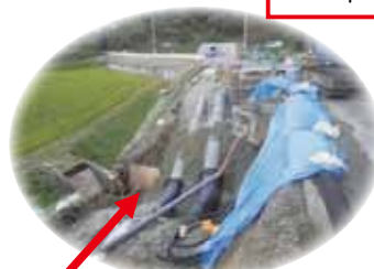
FRPM管（強化プラスチック複合管）の布設状況
