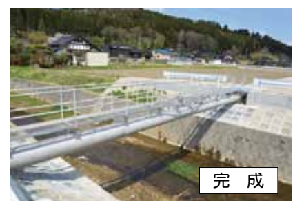
FRPM管（強化プラスチック複合管）の布設状況
