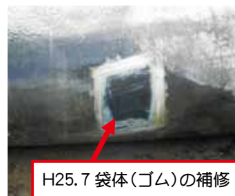
配管の空気漏れにより袋体が起立しない
