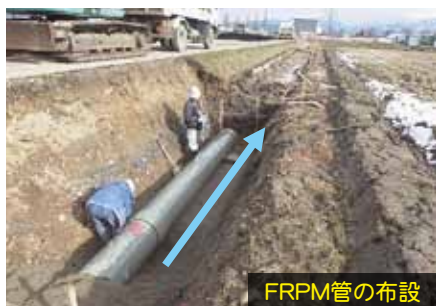
FRPM管敷設後 コンクリート水路を布設
