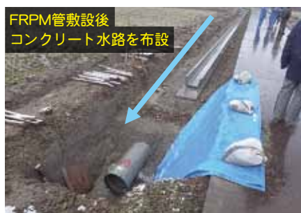
FRPM管の布設
