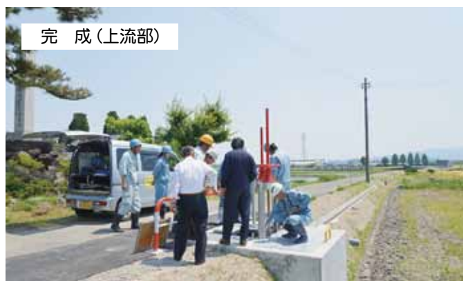
FRPM管敷設後 コンクリート水路を布設
