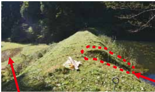
堤体からの漏水により農地の湿田化
